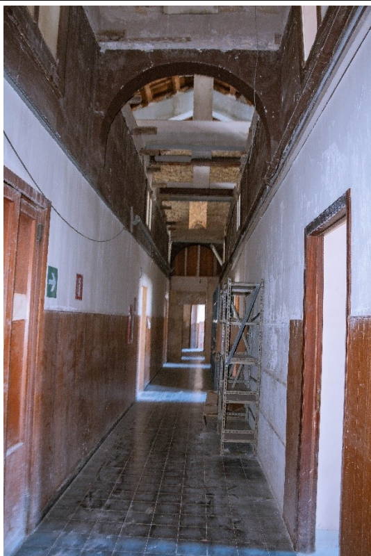
Foto 34. Piano terzo, corridoio nella zona da ristrutturare
