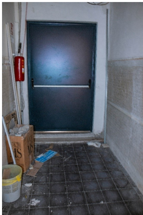
Foto 29. Piano secondo, corridoio con porta tagliafuoco nella zona da ristrutturare.
