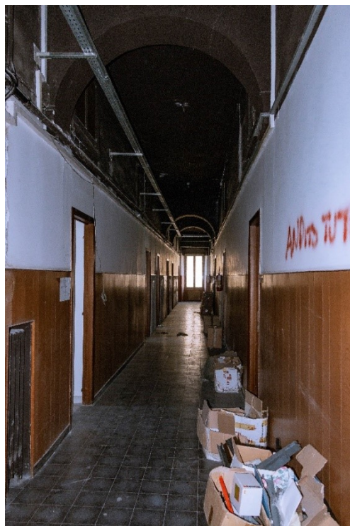
Foto 31. Piano secondo, corridoio lungo il fronte di via Sonnino nella zona da ristrutturare
