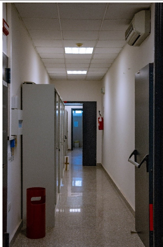
Foto 35. Piano terzo, corridoio nella zona archivi in uso.
