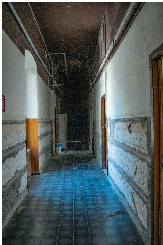
Foto 32. Piano terzo, corridoio nella zona da ristrutturare
