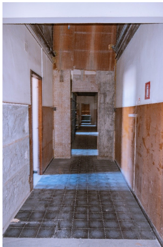
Foto 33. Piano terzo, corridoio nella zona da ristrutturare
