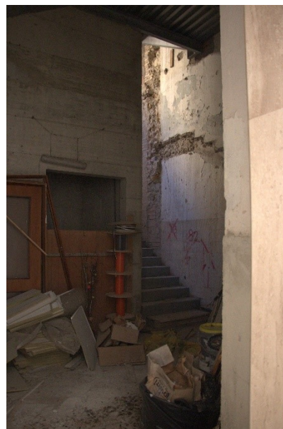
Foto 16. Vano scala con accesso carraio dalla via Sonnino da completare
