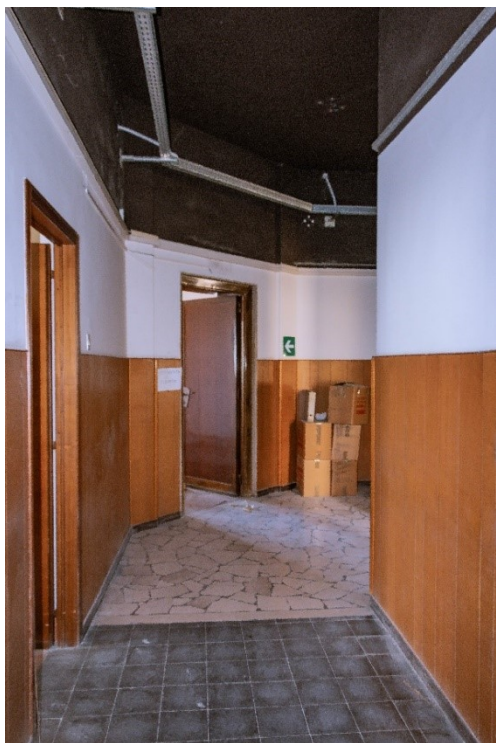
Foto 30. Piano secondo, corridoio con porta tagliafuoco nella zona da ristrutturare
