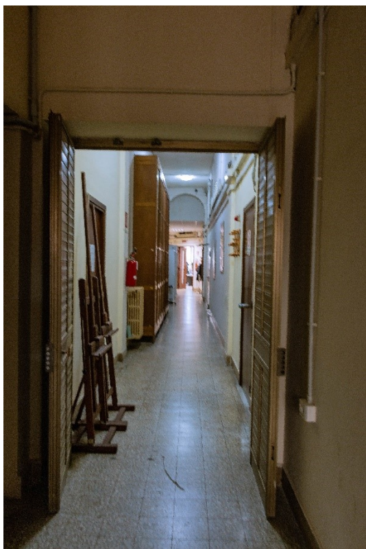
Foto 26. Piano primo, corridoio verso la sala di lettura in prossimità del vano scala da completare.
