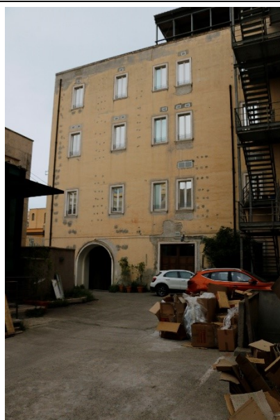
Foto 6. vista cortile ingresso verso uscita via Gallura
