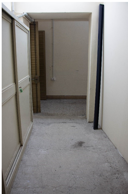
Foto 27. Piano primo, vano scala da completare verso il corridoio.
