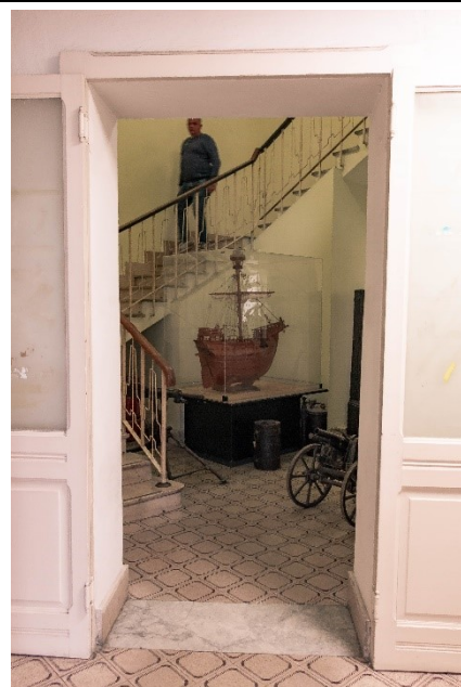
Foto 10. Vista del vano scala in posizione pressochè baricentrica
