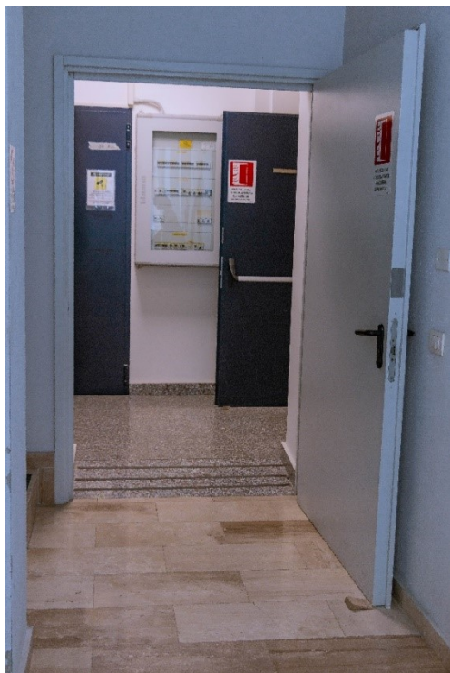
Foto 28. Piano secondo, raccordo pavimentazioni tra il vano scala con ingresso da via Gallura e il corridoio zona archivi
